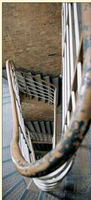
Wunderschönes historisches Treppenhaus im Umspannwerk „Christiania“, das um 1920 erbaut wurde.
